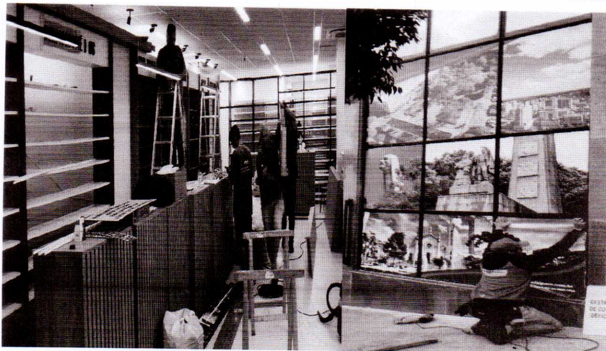
Montagem do mobiliário. Adesivagem do painel externo de vidro.
