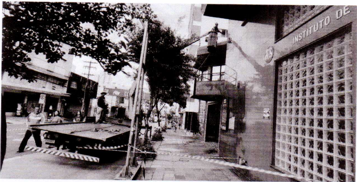
Lavagem da fachada.
