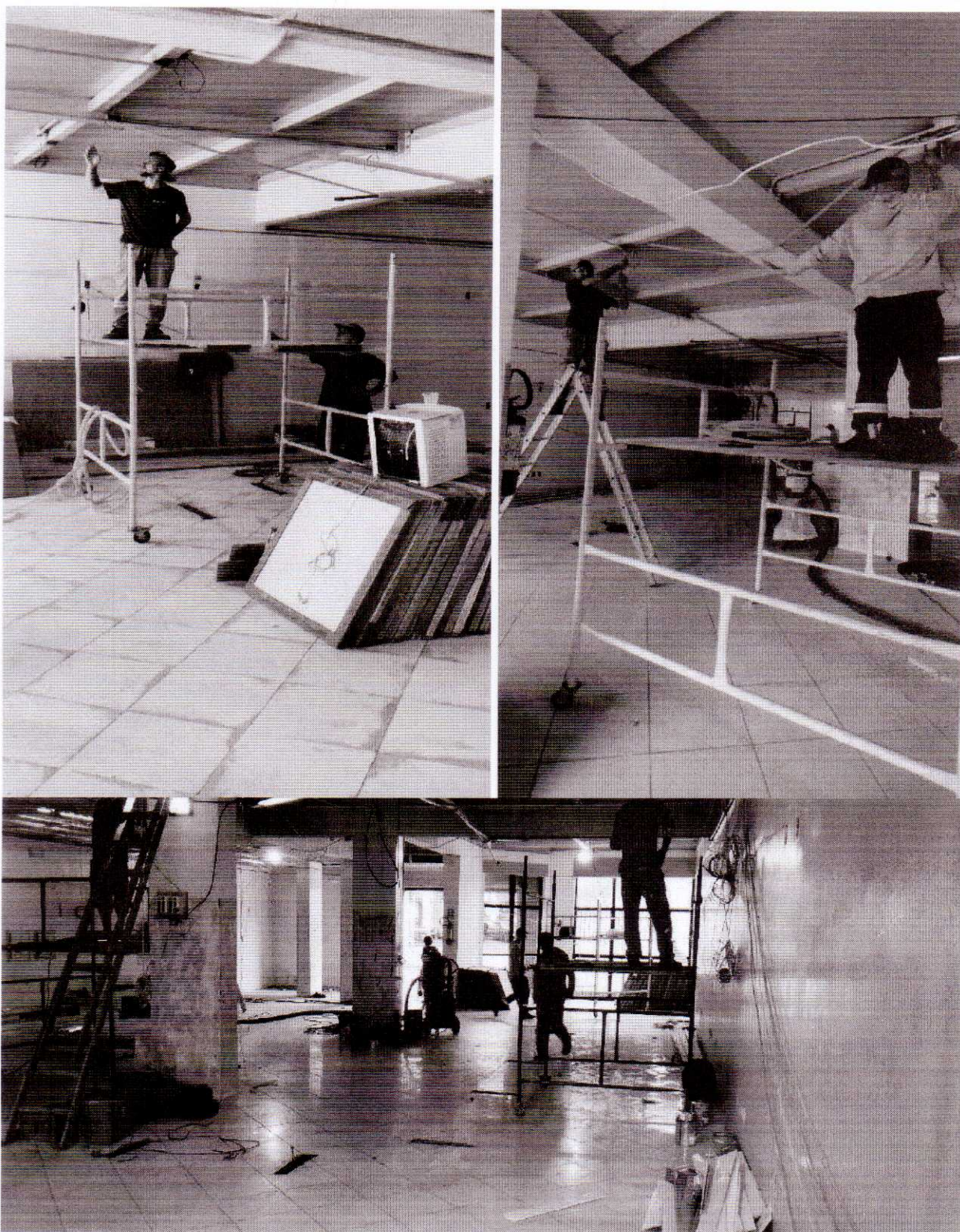
Retirada do cabeamento antigo. Instalação dos eletrodutos e passagem do novo cabeamento.
