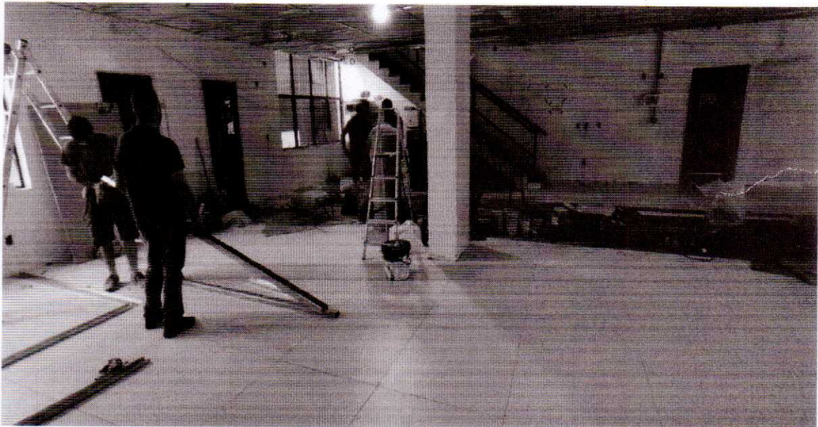
Instalação do drywall, para a criação de divisórias das novas salas.
