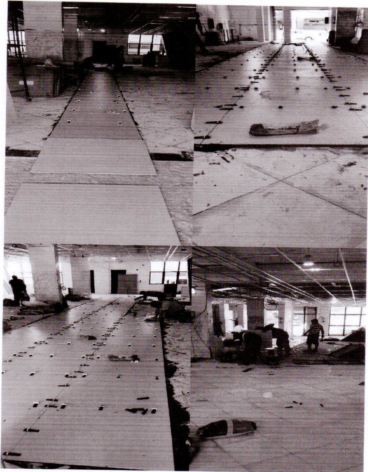
Instalação do revestimento em porcelanato.
