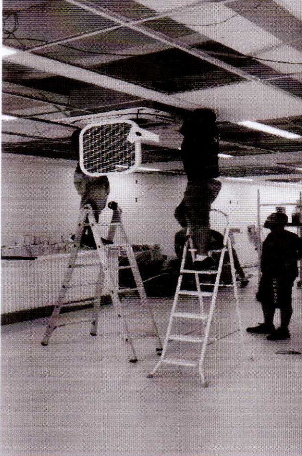
Instalação do sistema de refrigeração interna.
