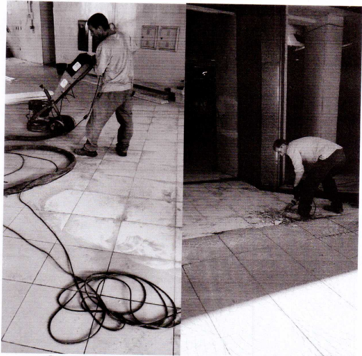
Preparação do piso para receber o novo revestimento em PORCELANATO. Realizado lixamento com a POLITRIX. Realizado a quebra do concreto com ROMPEDOR.
