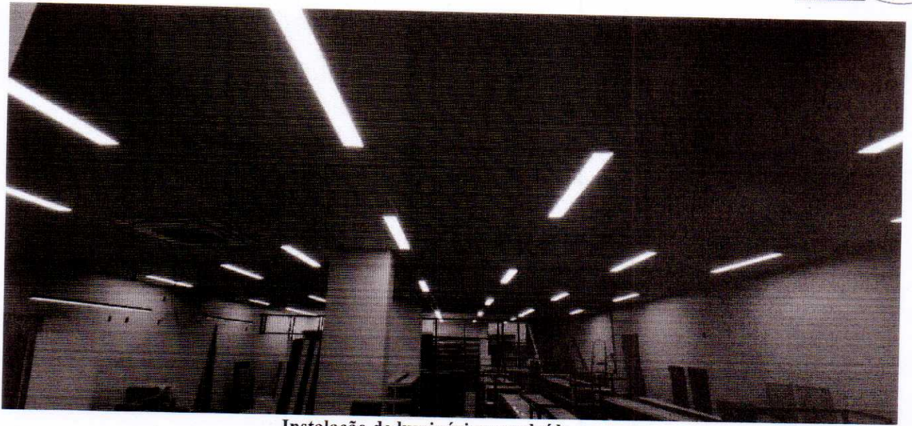
Instalação de luminárias concluída. Instalação do forro concluída.
