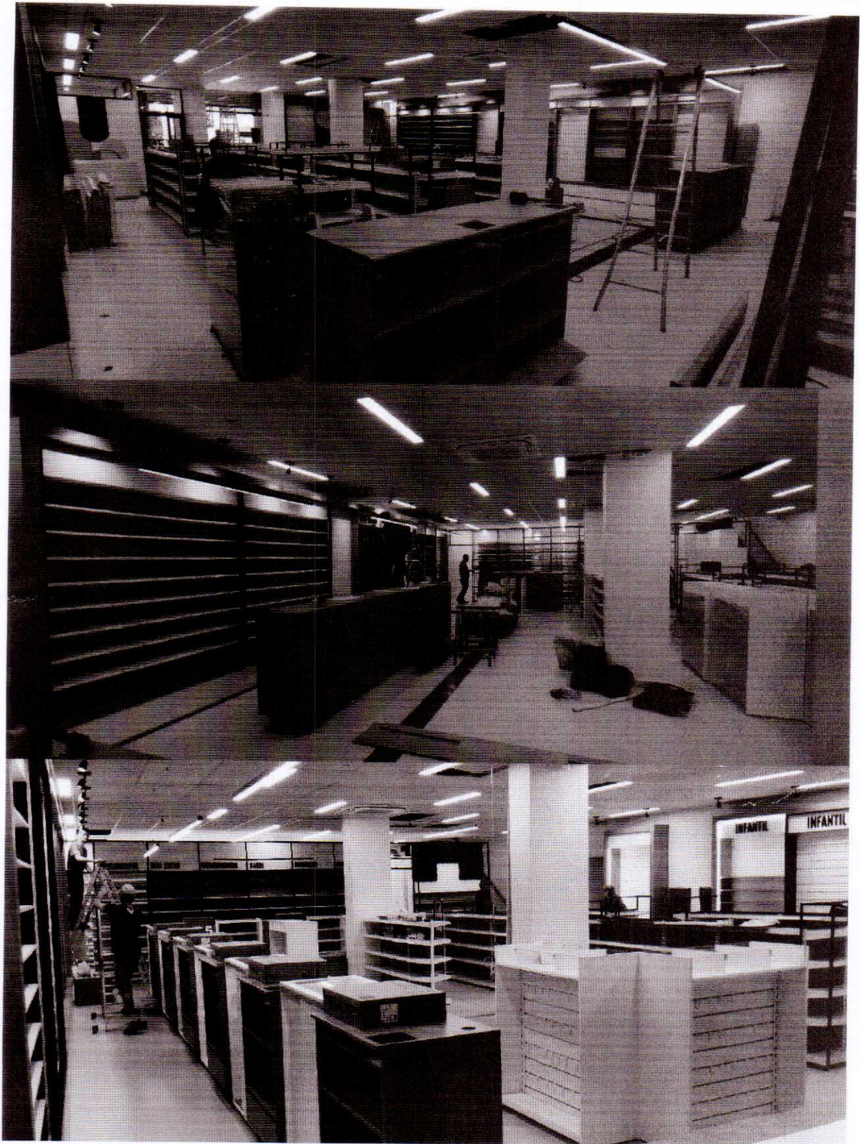
Montagem do mobiliário. Instalação iluminação fitas de led. Instalação das luminárias de teto.
